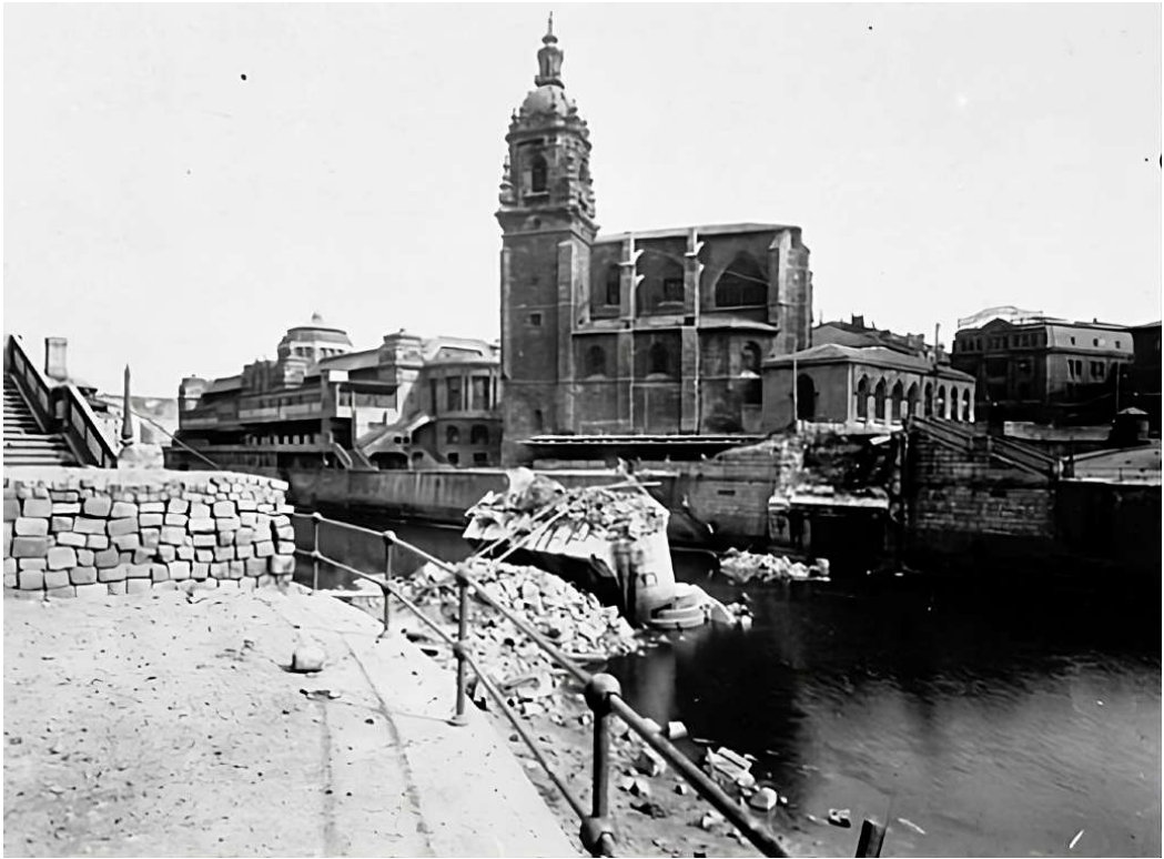
El puente de San Antón, uno de los que fueron volados en la ría de Bilbao en junio de 1937. (Archivo del Nacionalismo Vasco).
